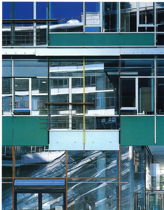
10 Glas in unterschiedlichen Farbtintensitäten und Stärken bringen die Fassade »zum Tanzen«
